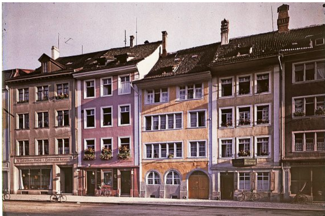
Farbige Häuser, Steinberggasse 31–35, Foto von 1926. Eines von über 75'000 Bildern, die im Online-Bildarchiv der Winterthurer Bibliotheken frei betrachtet werden können. Foto: Hermann Linck / bildarchiv.winterthur.ch
